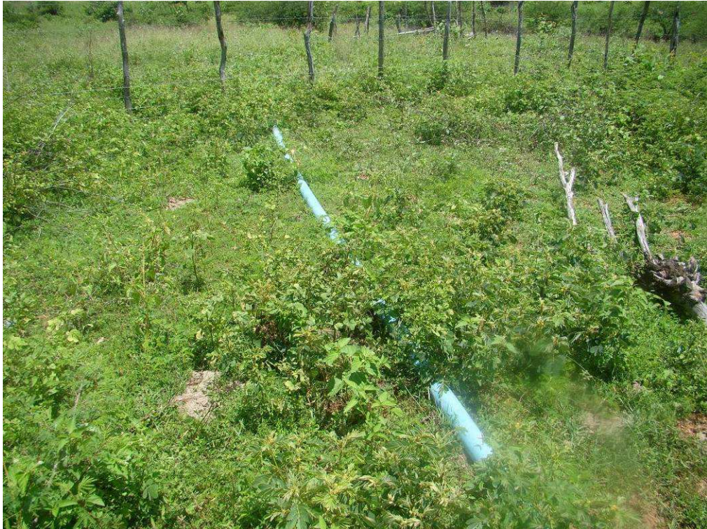
Tomada de água irregular, abastecendo um açude ao longo do canal (detalhe)
