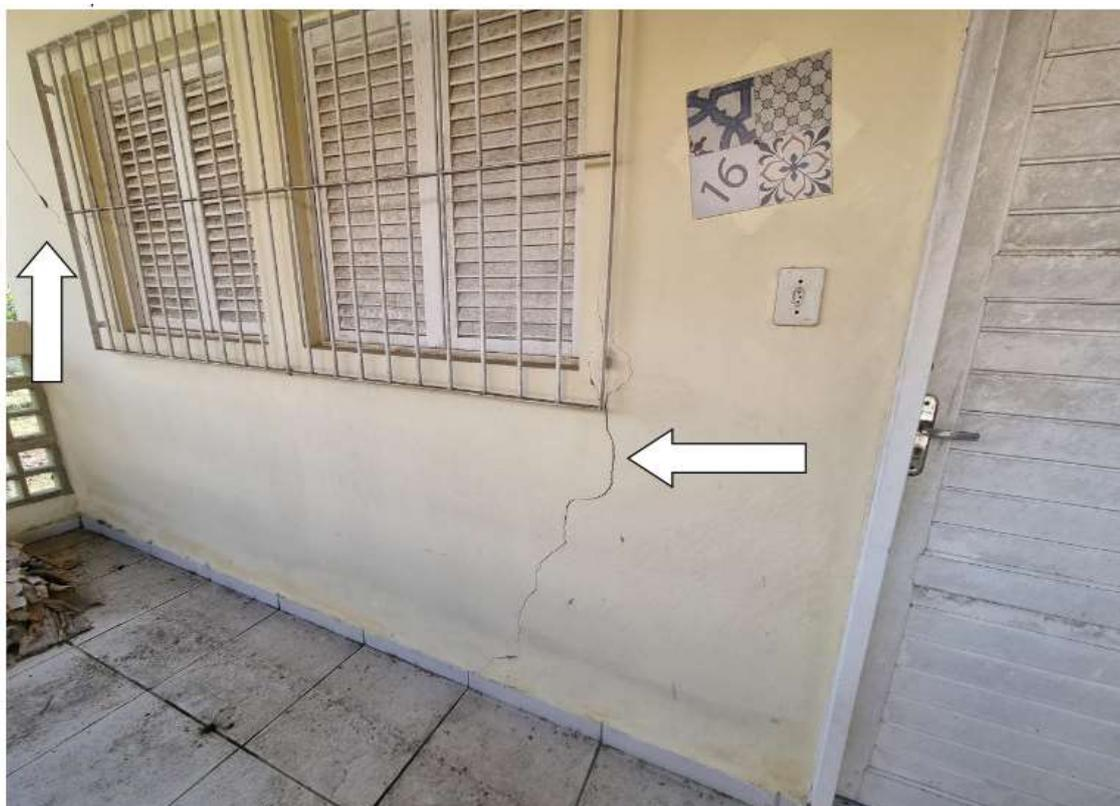
*Aspecto da parede frontal da unidade nº 16, apresentando rachaduras decorrentes de recalque (movimentação do solo).*
