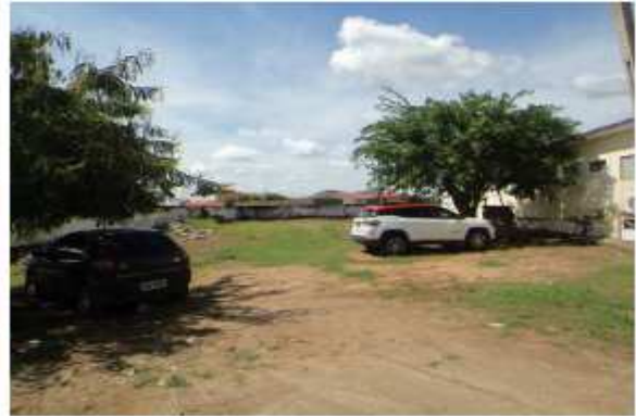
Unidade Mista de Saúde - João Moisés Sousa – Pátio de Estacionamento – Lado Esquerdo – veículos estacionados, com grande área livre para estacionamento de outros veículos.
